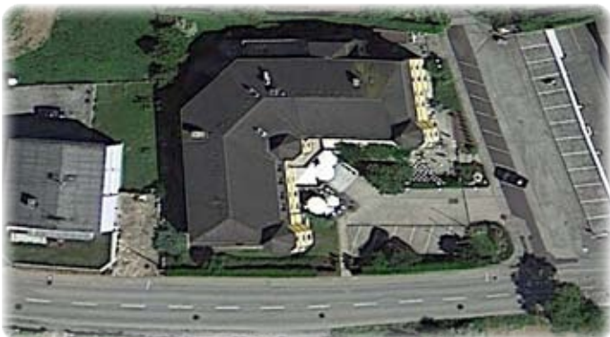
Umwidmung in Mischbaugebiet für das Grundstück Baderberg 7
