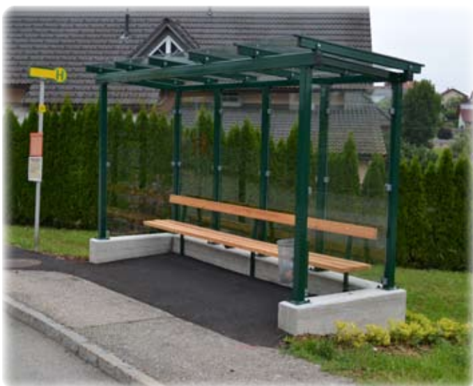
Unser neues Warthäuschen im Eichwiesel
