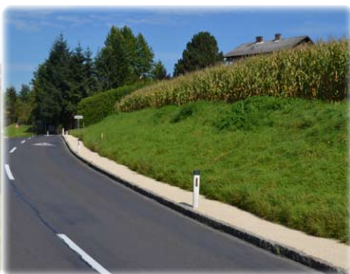
Der neue, provisorische Gehbereich in Neubodendorf
