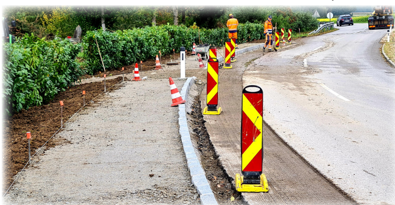
Gehsteigbau in Neubodendorf
