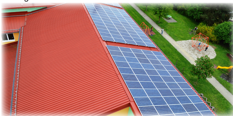
PV-Anlage am Volksschulgebäude
