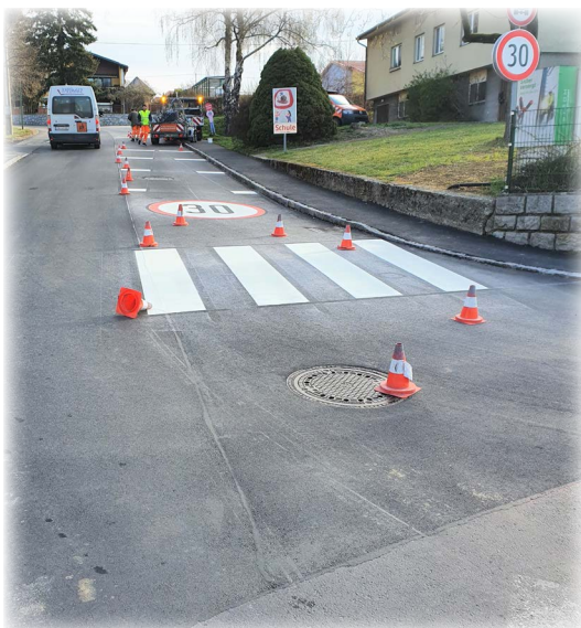
Schutzweg im Bereich Gemeindezentrum/Volksschule
