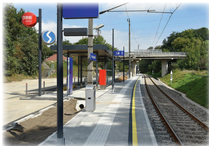
Neue Bahnhaltestelle in Katsdorf; Quelle: ÖBB
